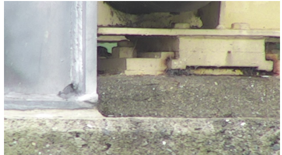
水管橋台座部分
